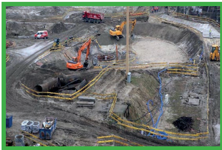
Szállítórendszer egy építkezésen.
