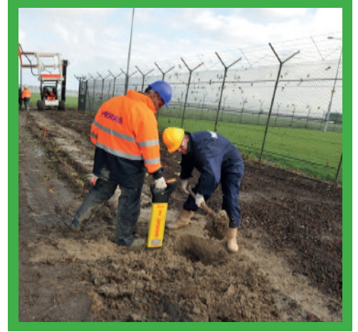
A kerítés felállítása előtt ellenőrizni kell, hogy vannak-e föld alatti kábelek.
