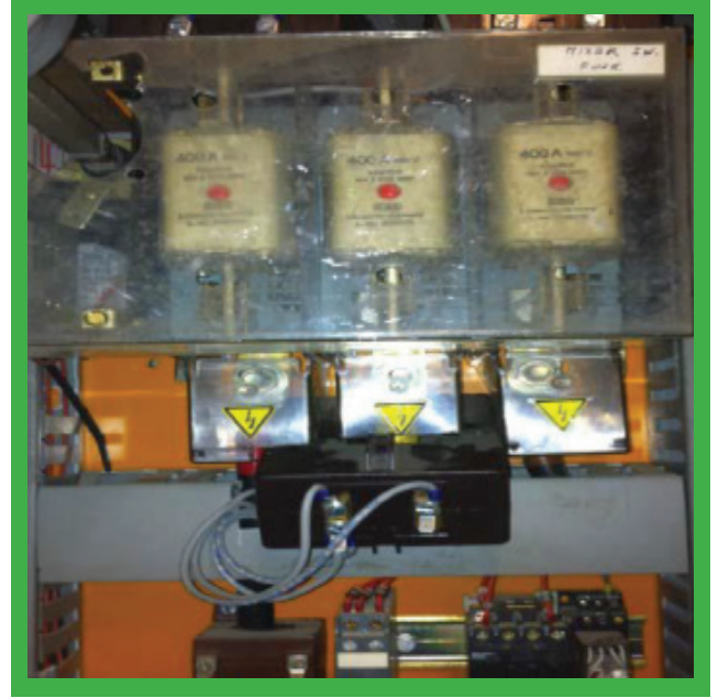
Minden feszültség alatt álló érintkezési pont borítással és burkolattal ellátva.
