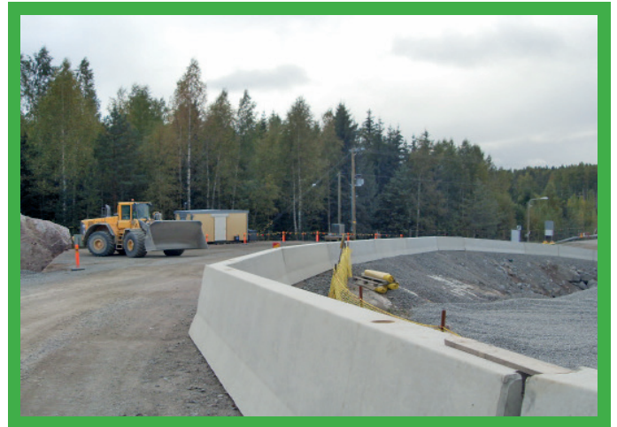
Út szélének védelme előregyártott betonelemekkel
