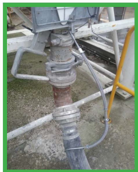
Tömlőögztítő biztonsági kábel.
