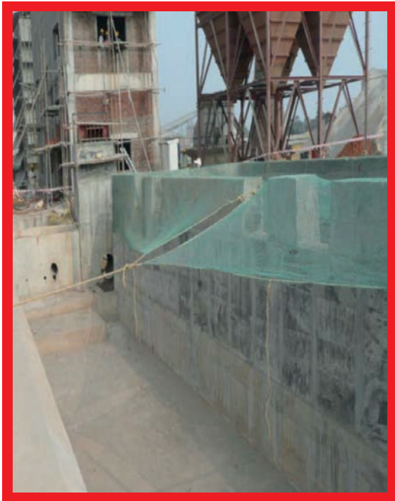
Halálos baleset, 2011: Egy vállalkozó lezuhant, amikor egy bővítés építésekor átlépett egy falon.
