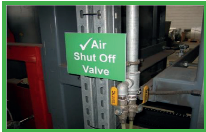
Egyértelműen azonosított pneumatikus leválasztási pont.
