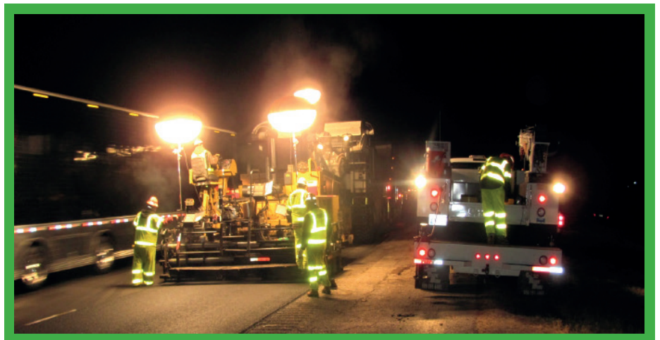
Élő forgalom közelében végzett éjszakai útburkolás.
