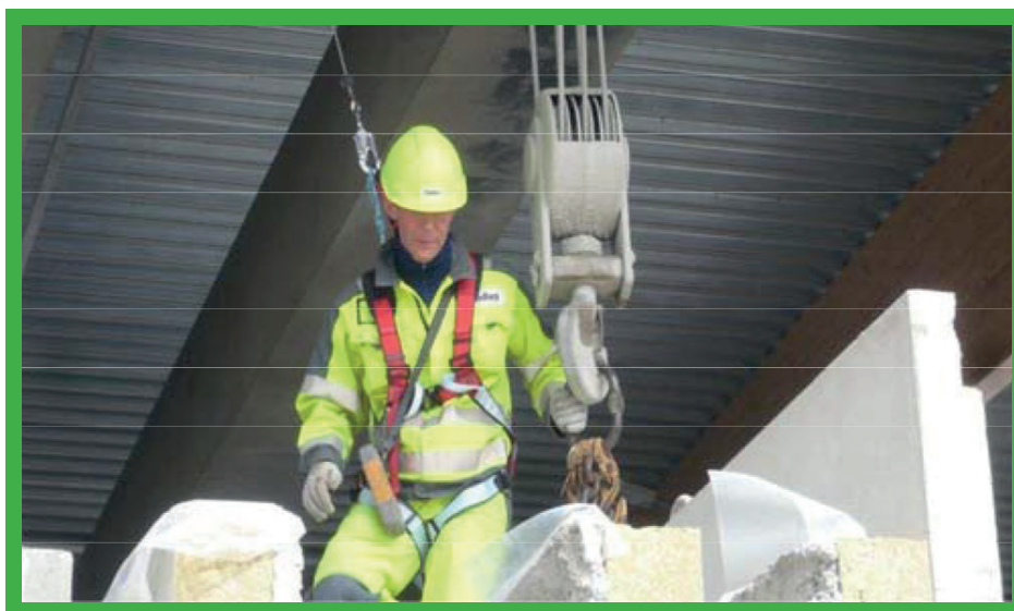
Biztonságos hozzáférési rendszer emelőhevederek rögzítéséhez és leválasztásához
