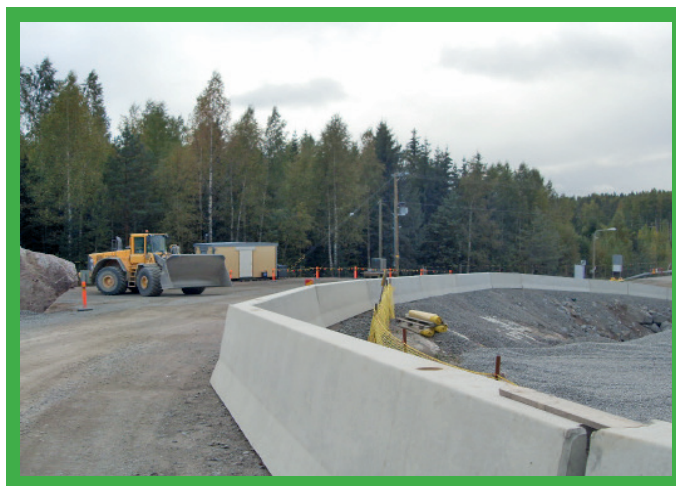
Ochranné bariéry z prefabrikovaných konštrukcií.
