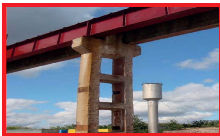
Smrteľné úrazy v rámci Skupiny – prípadová štúdia 2008: Dodávateľ počas zostupovania spadol z vyššieho poschodia. Pri určení rizík sa zistila potreba použitia systému MEWP (pojízdnaj vysokozdvížnej pracovnej plošiny), ale žiadna sa nepoužila.
