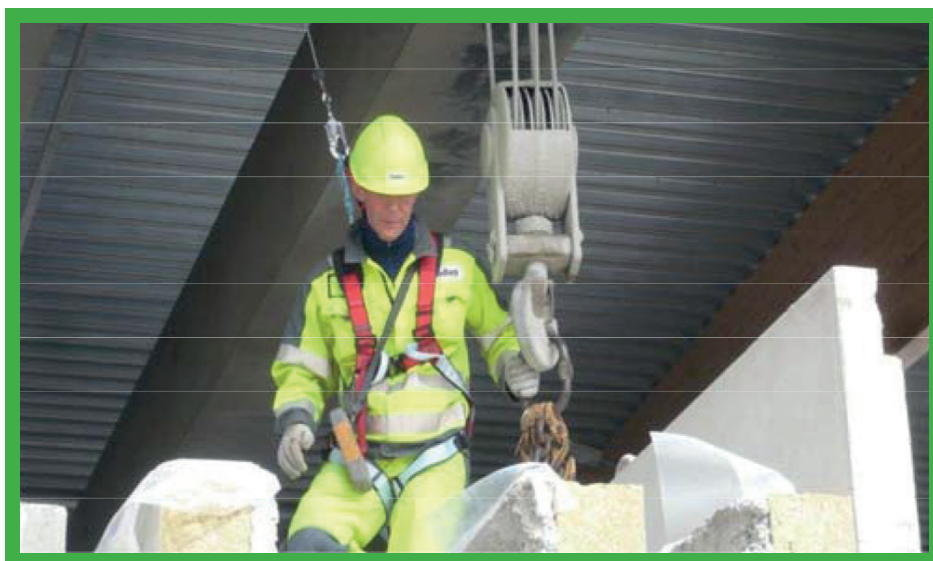
Bezpečný systém prístupu pre pripevnenie a odpojenie zdvihačích popruhov
