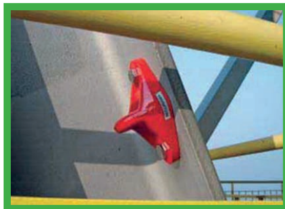
Kotviace body – inštalované v prípade potreby.
