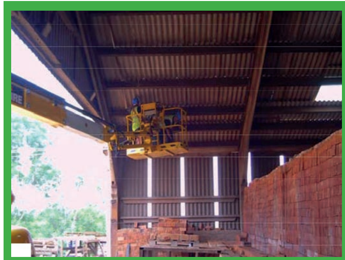
MEWP sa aktívne využíva v tehelni a cementárni.
