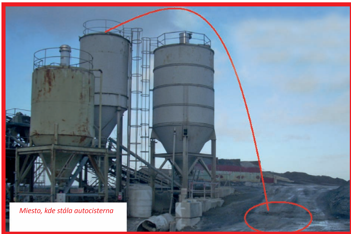
Incident - skoro nehoda 2019: Filter bol vymrštený do neďalekej zóny
