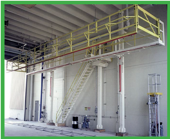
Systém v Finnsementi na ochranu vodiča cisternového vozidla počas nakladania. Tento systém sa dokáže prispôbiť čo sa týka dĺžky a výšky vozidlám všetkých rozmerov.
