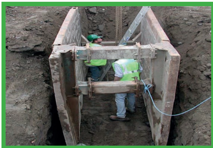
Paženie výkopu v praxi
