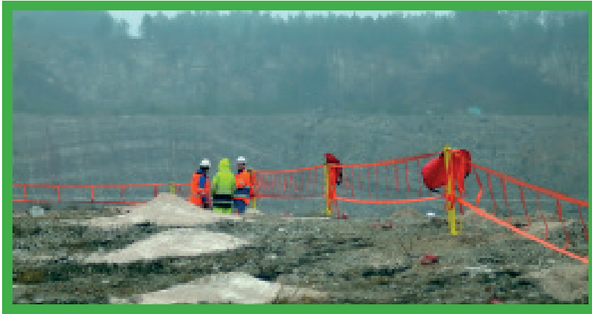
System bariér na lomovej stene.
